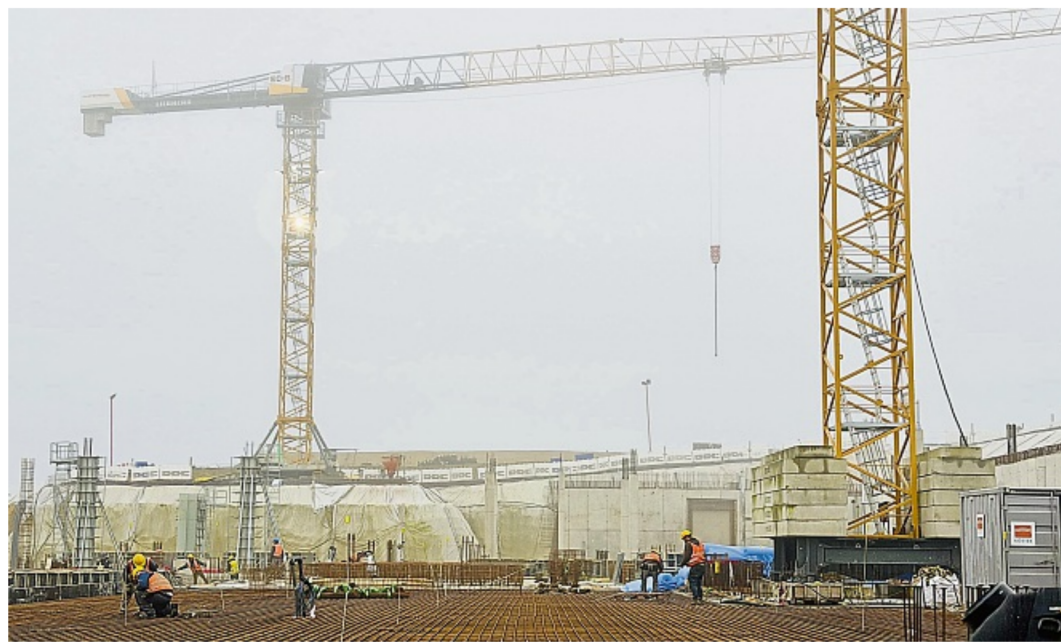
Blick aus der Baugrube auf die massiven Turmkräne: Die Arbeiten für die Zentralklinik laufen laut Kreisverwaltung nach Plan. JANNICK RIPKING
