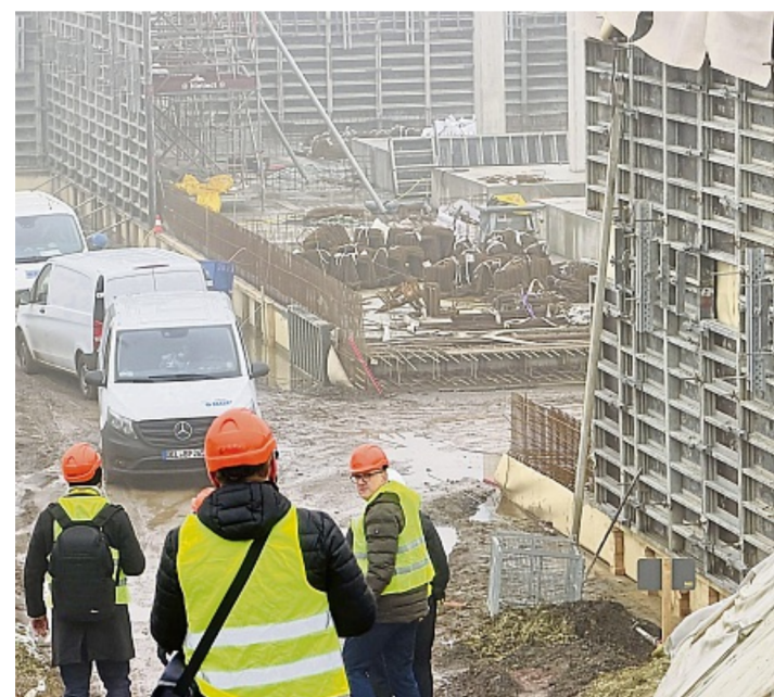
Auf dem Weg nach unten: Zurzeit stehen Fundamentarbeiten in der Baugrube des Zentralklinikums an. JANNICK RIPKING
