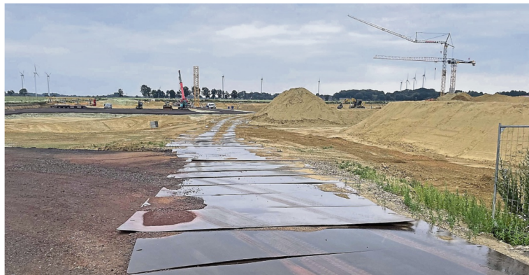
Die Grundwasserabsenkung auf der Großbaustelle verläuft langsamer als geplant.
