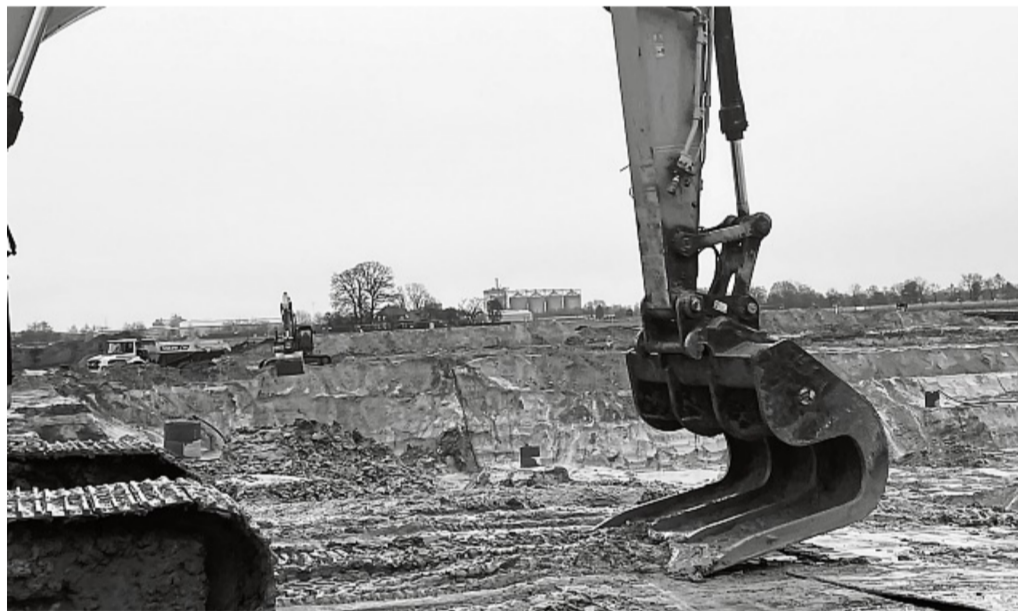
Die Baugrube für das Zentralklinikum – in diesem Fall bewusst so fotografiert von Uwe Lorenz – nimmt Formen an.
