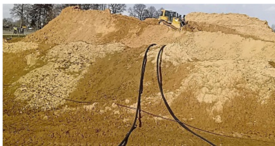
Wie ein Spielzeug wirkt die Raupe auf der Großbaustelle für das Zentralklinikum in Borwede
