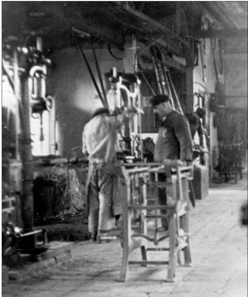
Bau von Stroh­hülsenmaschinen in der Maschinenfabrik A. H. Meyer in Twistringener, um 1950. Die Konstruktion hatte sich gegenüber der direkten Vorkriegszeit nicht geändert. Museum der Strohverarbeitung, Twistringener
