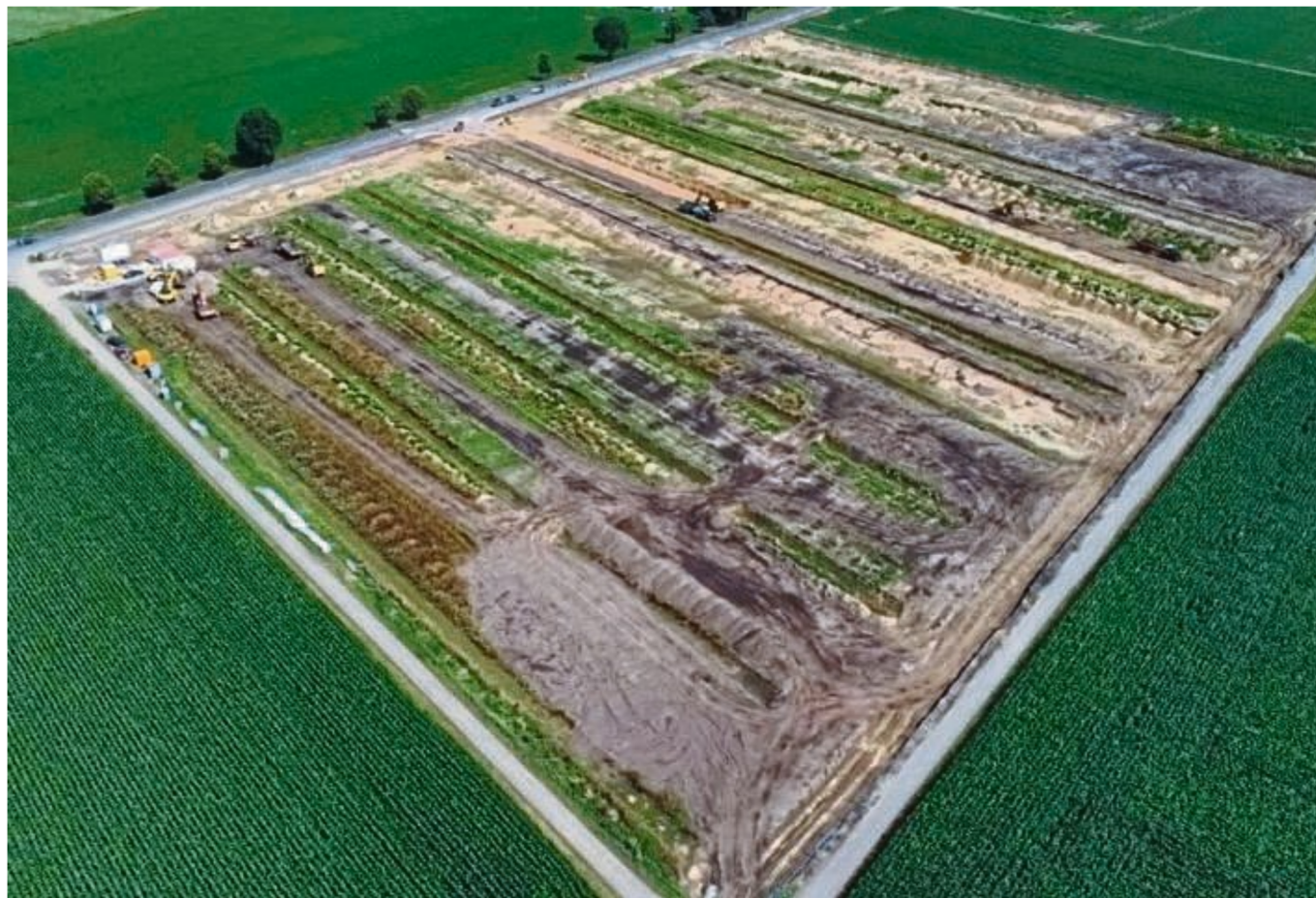
Die Tiefbauarbeiten auf dem Klinikbaugelände in Borwede haben längst begonnen.
